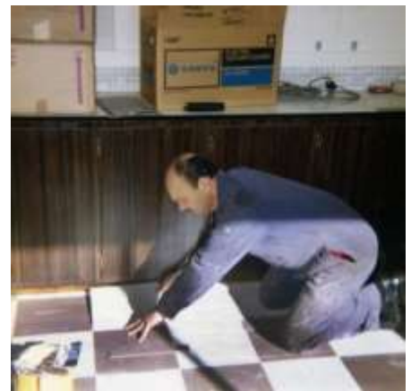
Jack Burcon laying tiles.
